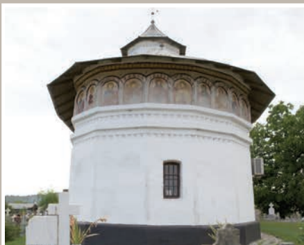
Fațadă Est-Absidă Altar
