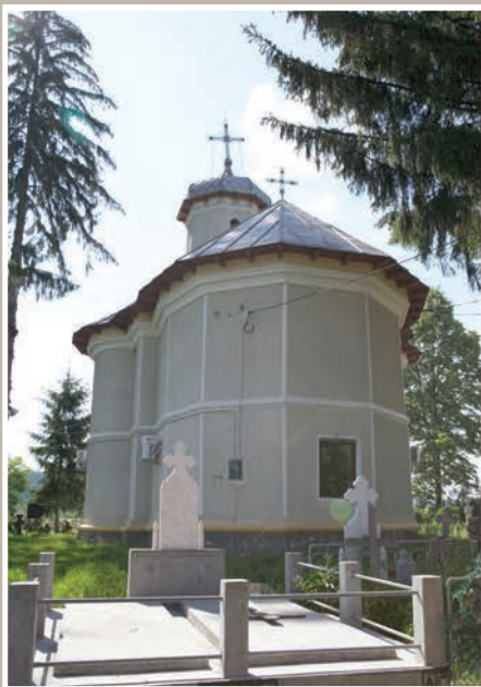
Fațadă Est-Absidă Altar
