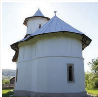
Fațadă Est (Absidă Altar)
