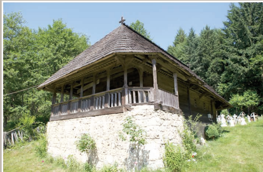
Vedere Sud Vest-Pridvor deschis
