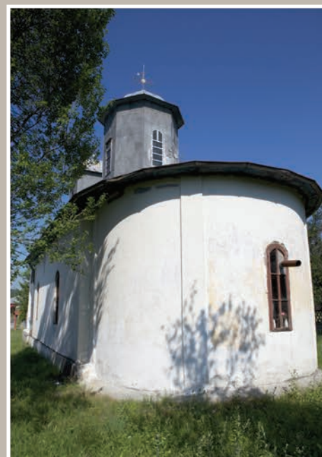
Fațadă Est-Absidă Altar
