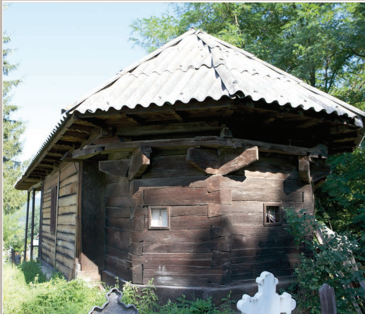
Fațadă Est-Absidă Altar
