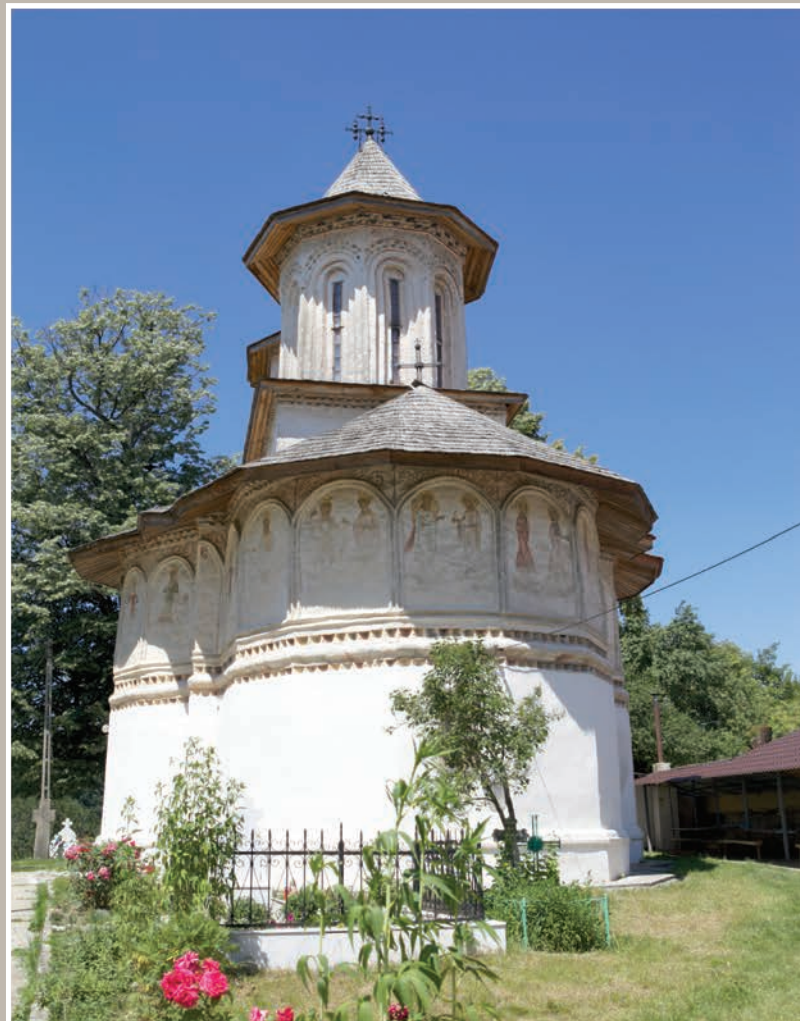
Fațadă Est-Absidă Altar
