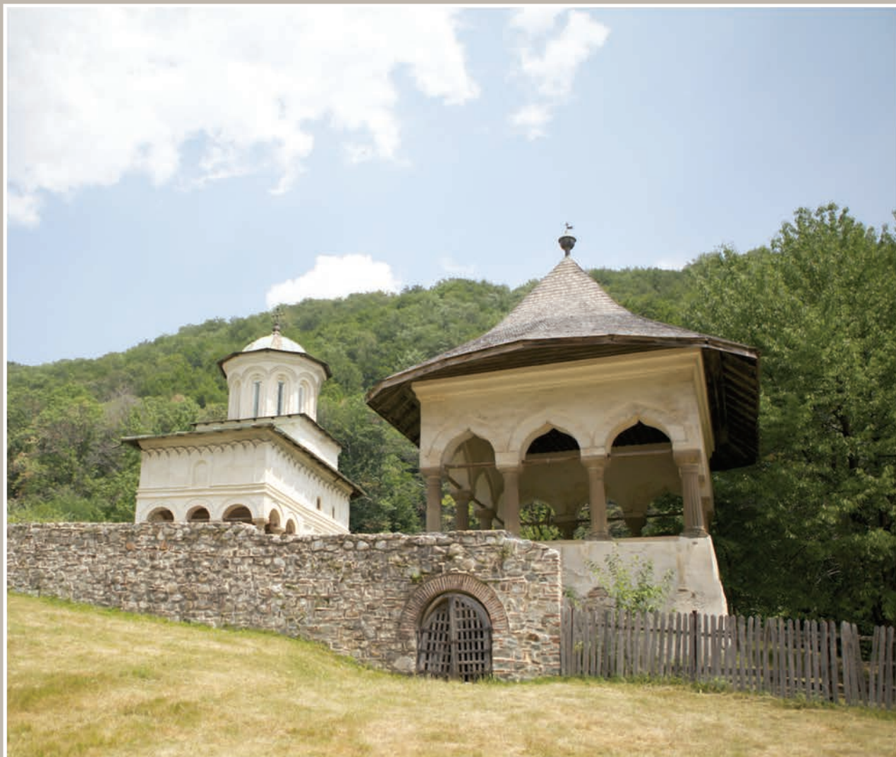
Vedere Exterioară – Ansamblul Bolniței
