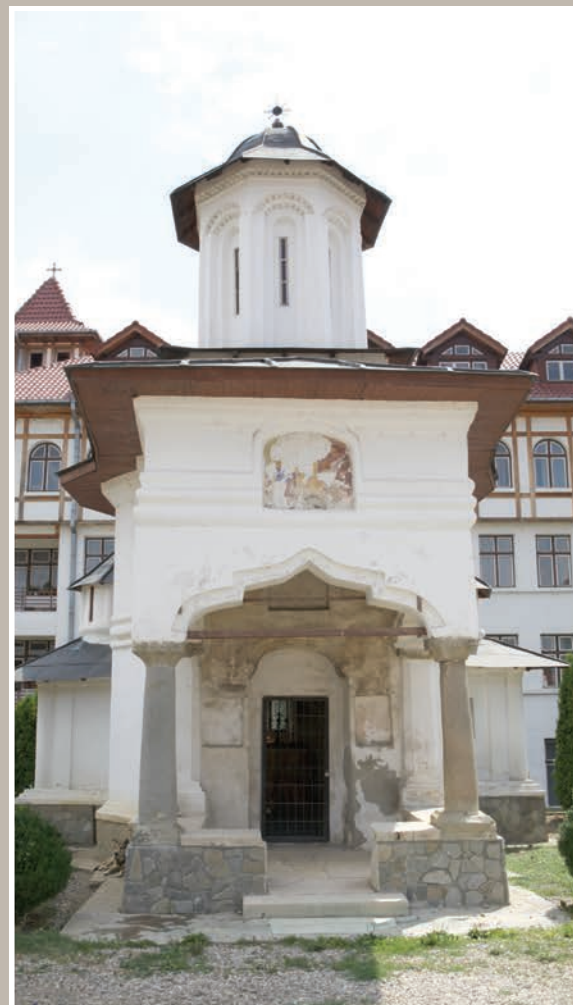
Biserica Fostului Schit, Fațadă Vest-Pridvor
