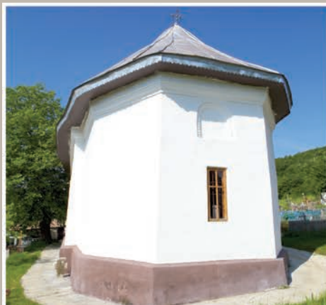
Fațadă Est-Absidă Altar
