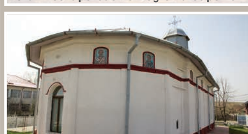
Fațadă Est (Absidă Altar)
