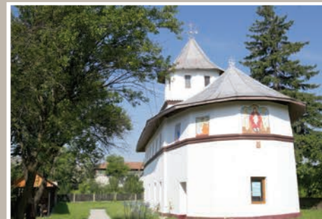
Fațadă Est-Absidă Altar
