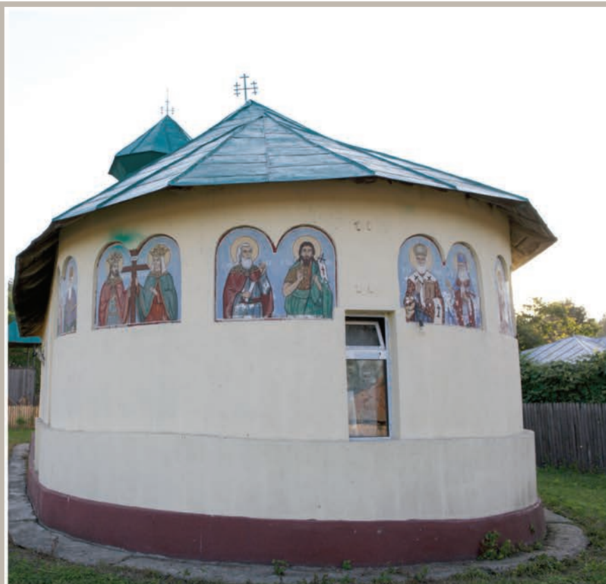
Fațadă Est-Absidă Altar
