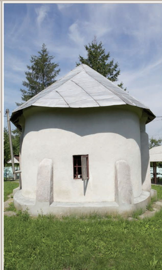
Fațadă Est-Absidă Altar
