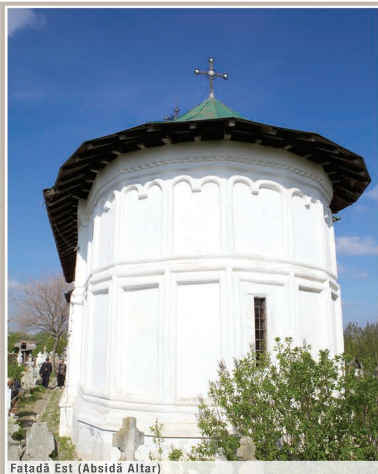
Façadă Est (Absidă Altar)
