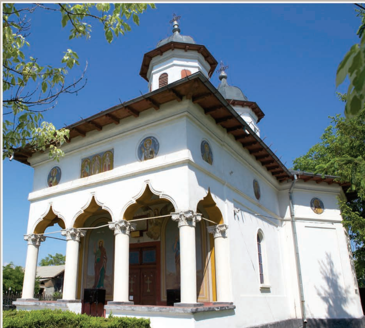
Vedere Sud-Vest - Pridvor Deschis
