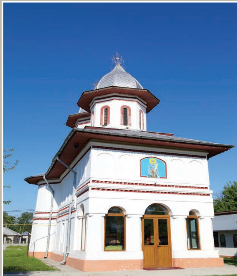
Vedere Nord-Vest – Pridvor cu Tablou Hram
