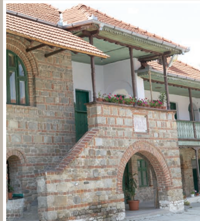
Vedere din curtea interioară a mănăstirii
